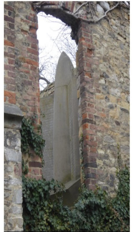
Blick auf die Kriegergedächtnisstätte durch ein Fenster der Ruine Granau
