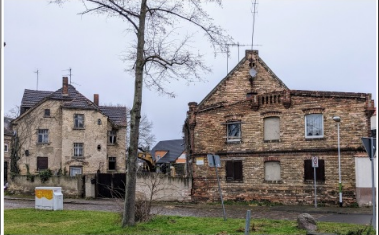
Abrissarbeiten am ehem. Großmann'schen Haus (links) am Gustav-Menzel-Platz Foto: Lutz Scholz / 11.02.2024
